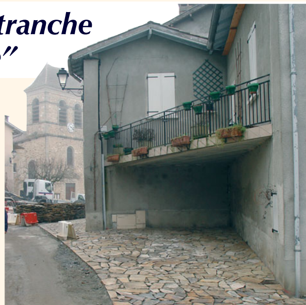
Création d'un cheminement piétonnier et réfection de la chaussée pour les rues situées aux abords de l'église.
