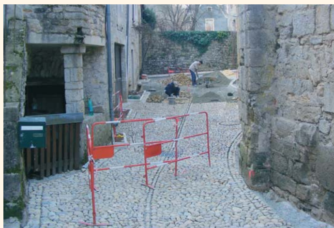
Les abords de l'abbatiale et les ruelles en cours de traitement.
