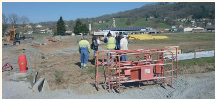
Réunion de chantier courant mars.
