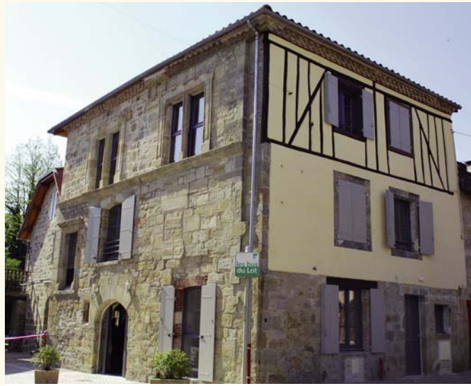
... et après travaux.
