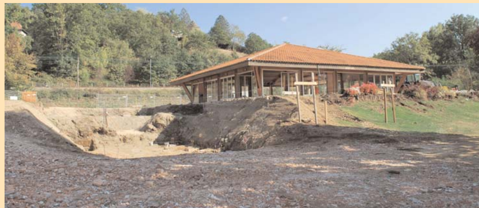
Le chantier courant septembre
